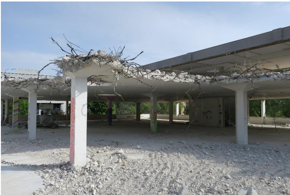
Le chantier nécessite une coordination entre démolition lourde et déconstruction - Source : Société Coopérative 2401
